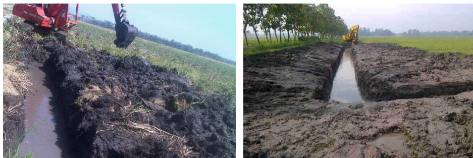
Gambar 15. Proses Pembuatan Saluran Drainase dengan Backhoe
